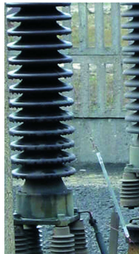
Bild 4. Massivstützer SWZP4 mit spezieller Sicherung
