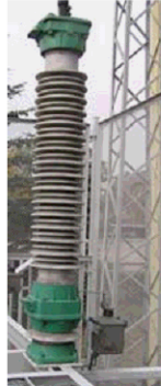
Figure 4: Paratonnerre GXA106 avec une couche hydrophobique
